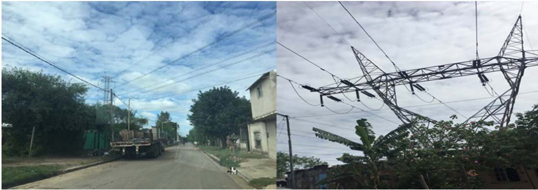
Figura 24: Viviendas debajo de líneas eléctricas de alta tensión
