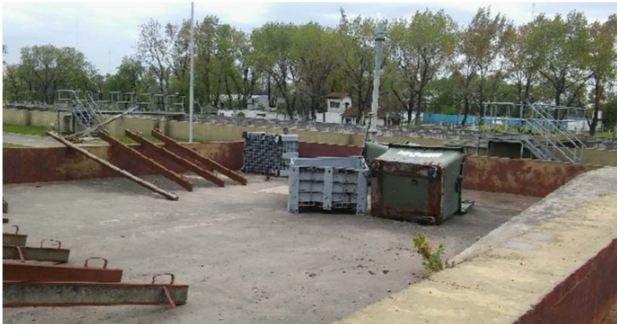
Figura 13: Elementos considerados chatarra dentro de la Playa de secado y crecimiento de plantas dentro de la instalación
