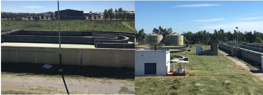
Figura 6: Situación actual de la Planta.
