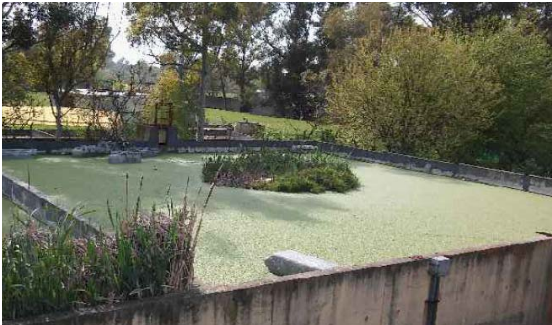
Arbustos en reactores y aireadores fuera de funcionamiento
