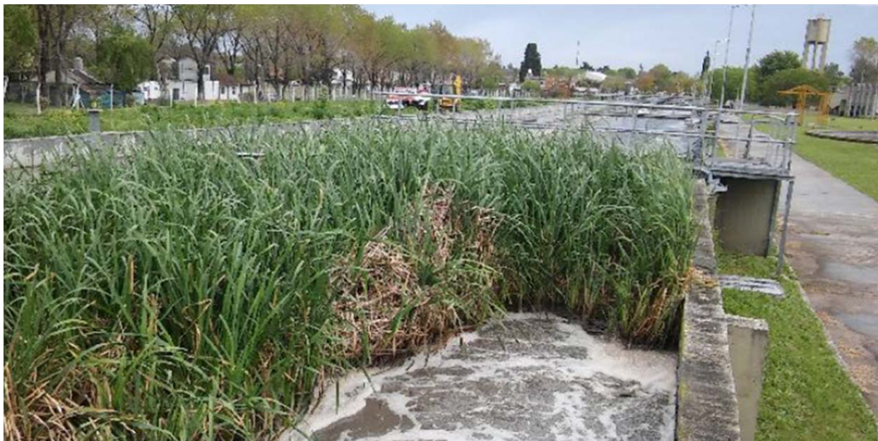
Figura 14: Juncos en la Zanja de oxidación
