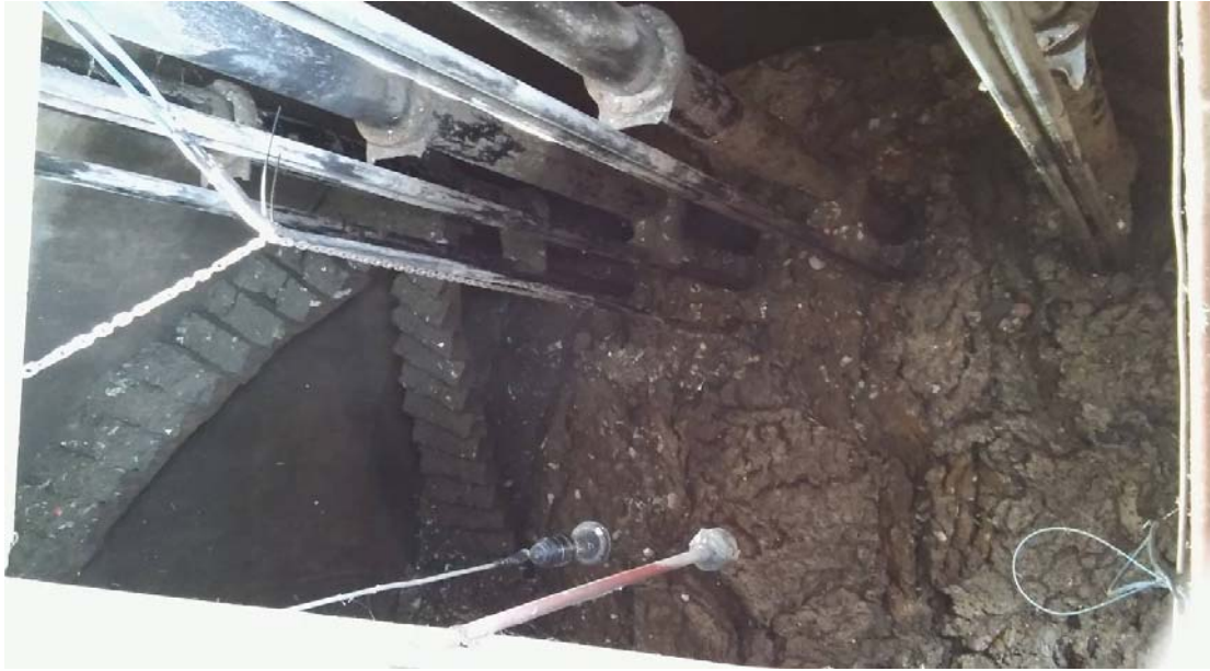
Barros en Estación de Bombeo de Ingreso.
